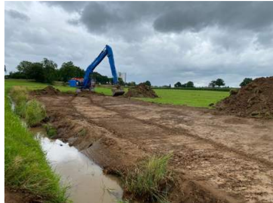
Uitvoering van de werkzaamheden aan de Campagnebeek.
